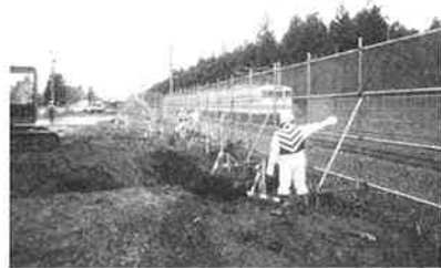
写真-5 線路防護柵設置状況
