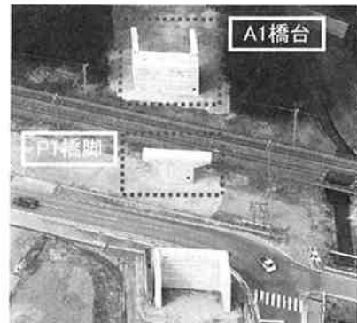
写真-1 完成写真 (A1橋台・P1橋脚)
