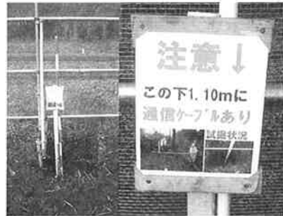
写真-4 埋設物目印看板設置状況
