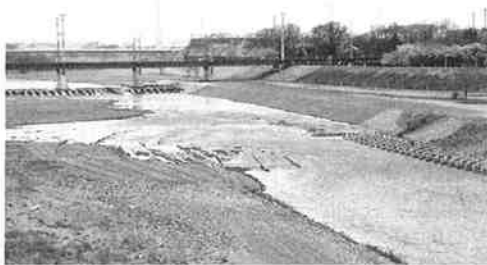
写真-1 完成写真
