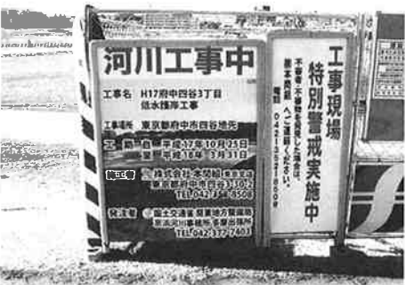
写真-3 標識、仮囲いの第三者安全対策
