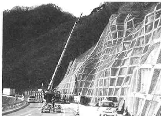
写真2 落石防止網設置状況
