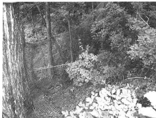
写真3 仮設落石防止柵詳細
