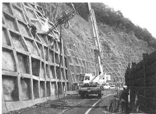
写真1 グラウトロックボルト削孔状況
