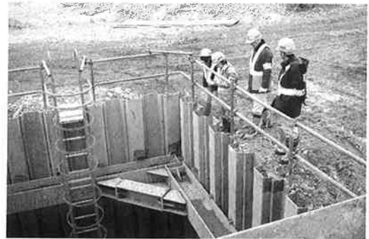
写真-5 安全巡視状況
