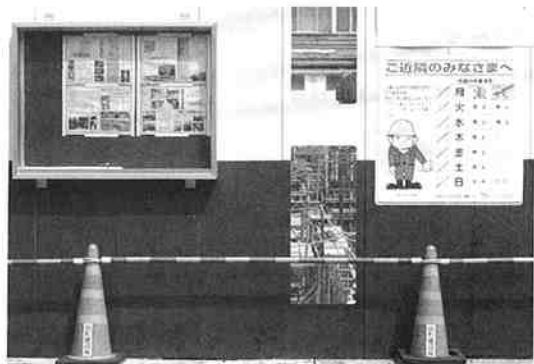
写真-2 掲示板・工程表
