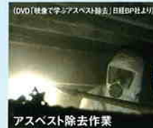
アスベスト除去作業
