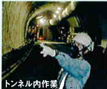
トンネル内作業
