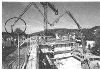
写真1 ポンプ圧送の海外の事例
