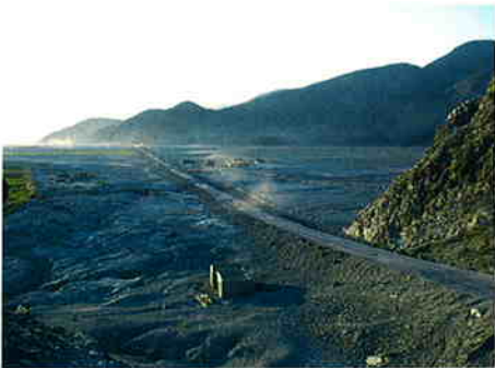
大かんばんの影響で緑を失う。(用水路建設前)
