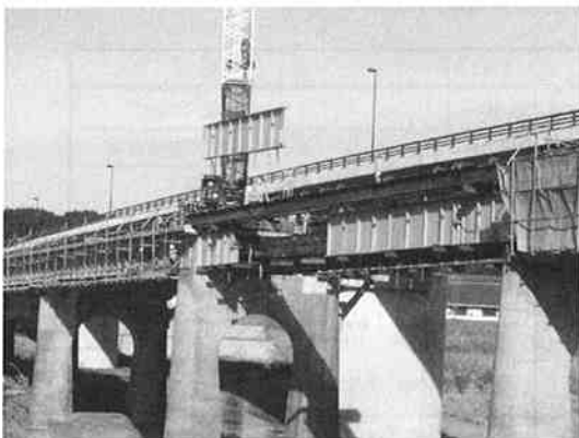
写真-6 切断主桁撤去状況
