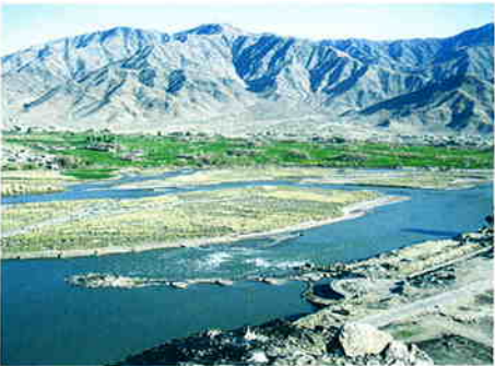
クナール河に設置した斜め堰
