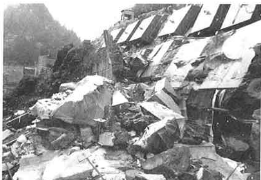
写真-1 軽量盛土崩壊
