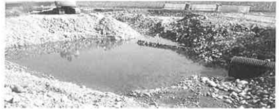
写真-5 沈砂池設置状況
