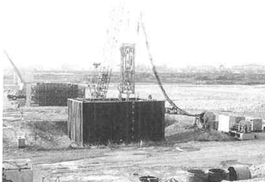
写真-3 デュアルジェットシステム設置状況 (全体)
