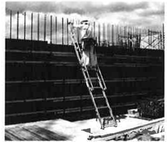
型枠昇降用移動はしごの使用状況
