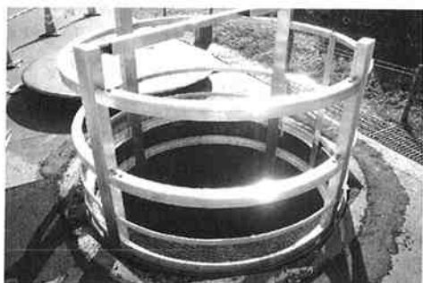
立坑に設置した手すり
