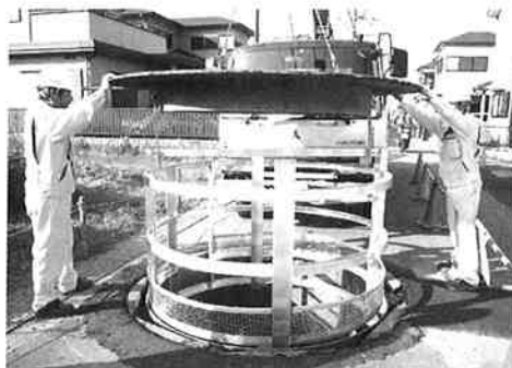
覆工板につられて推進坑から取り出し中の手すり
