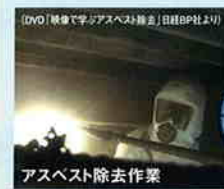
アスベスト除去作業
