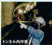
トンネル内作業
