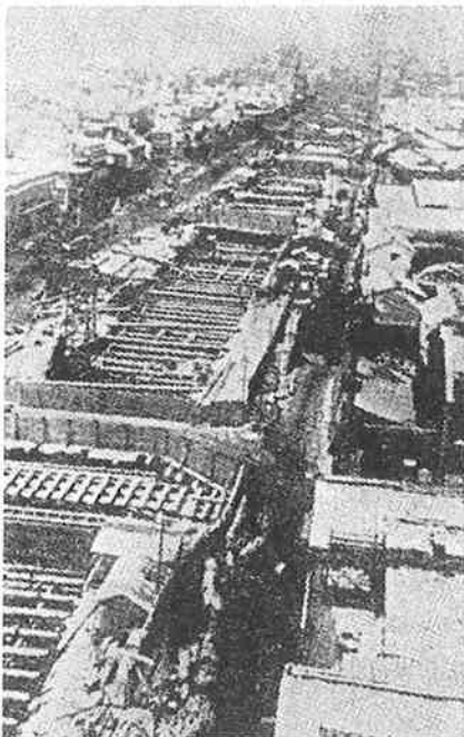
写真-1 戦前の開削工事（大阪地下鉄）
