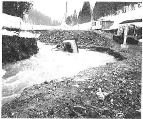
写真-1 被災状況
