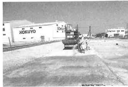
写真-5 飛砂・粉塵防止剤の散布
