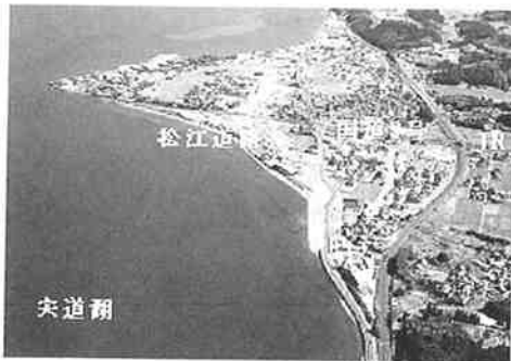
写真-1 松江道路（玉湯工区）
