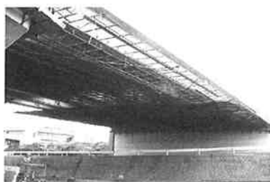
写真-3 吊り足場設置完了
