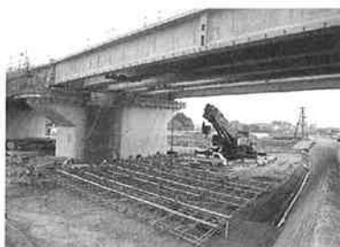
写真-1 足場地組状況
