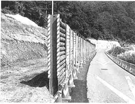
写真-2 仮設防護柵及び安全対策
