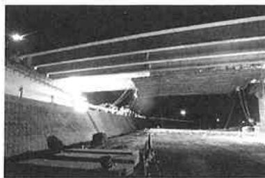
写真-2 吊り足場移動
