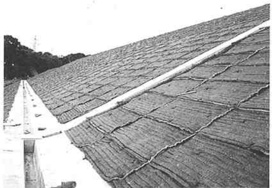
写真-2 対策後完成
