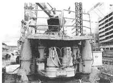
写真-1 ケーシング内土砂の投入状況
