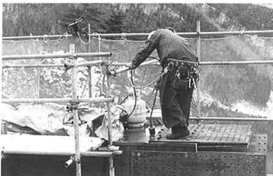
写真-7 ジョイント部乾燥状況
