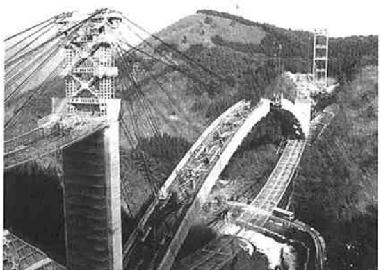
写真-2 アーチリブ斜吊架設（多点吊方式）
