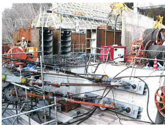
斜吊索固定用アンカー設備（19頁）
