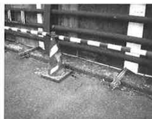
写真-3 落下防止柵内側下部
