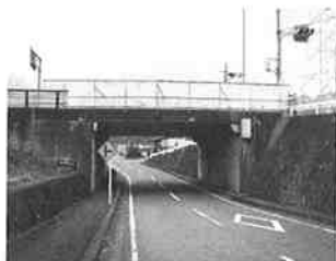
写真-1 交差道路より落下防止柵外側
