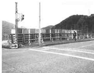
写真-2 落下防止柵内側
