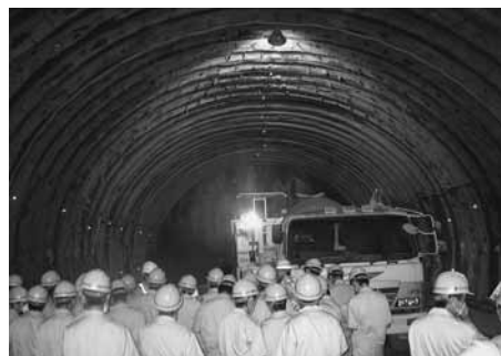
芳ノ元トンネル工事
