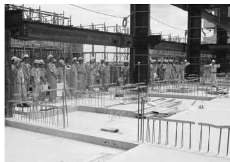
県営住宅花ヶ島団地5号棟
