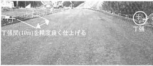
写真-1 丁張間の仕上げ
