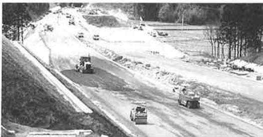
写真-2 上層路盤施工状況
