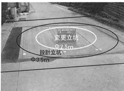
写真-5 立坑完了
