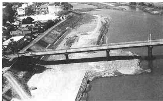
写真-8 着手前状況
