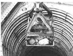
写真-3 立坑掘削
