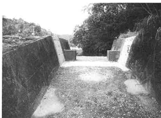
写真-3 補修後の敷張コンクリート
