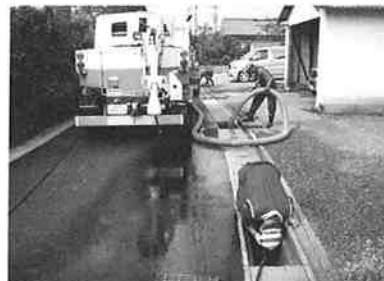
写真-14 側溝の掃除
