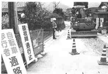
写真-10 昼休みの安全監視状況
