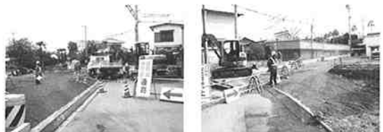
写真-7 仮設道路
