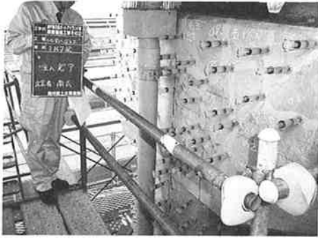
写真-7 柱部へのひび割れ注入状況1
