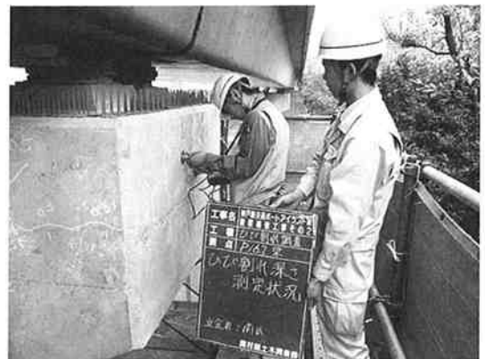
写真-3 ひび割れ深さ調査状況
