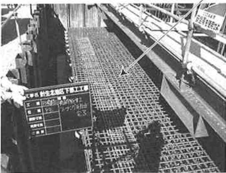
写真-3 改善鉄筋足場による鉄筋組立完了状況
