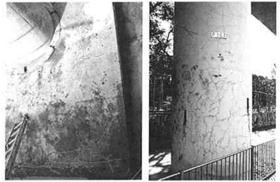
柱 フーチング
