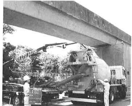
写真-11 梁部への打込み状況
