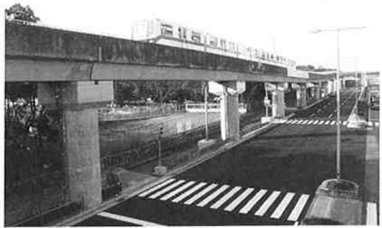
写真一12 施工完了
