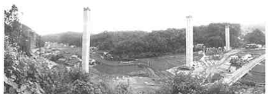
写真-2 橋脚全景
