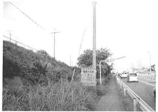
写真-1 施工箇所写真
