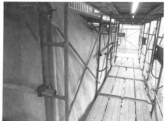
写真-4 ブルーシート養生
