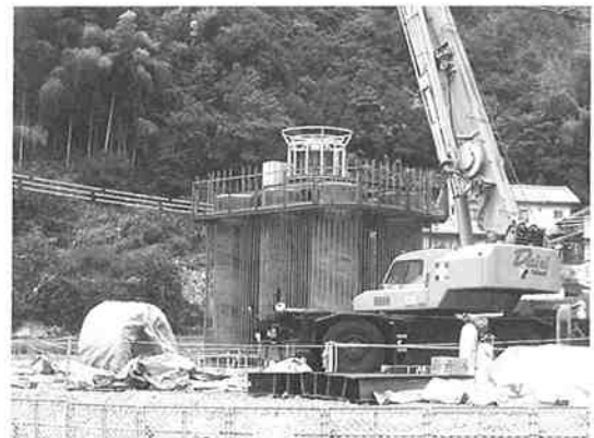
写真-1 橋脚全景
