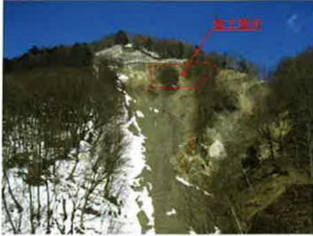
写真-1 施工前全景 (3月)
