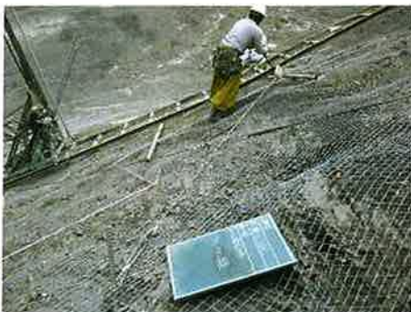
写真-5 クライマードリル移動状況
