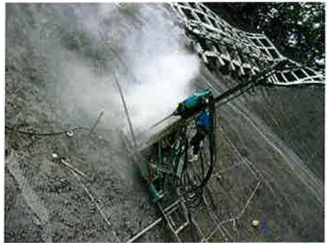
写真-4 ロックボルト施工状況(2)
