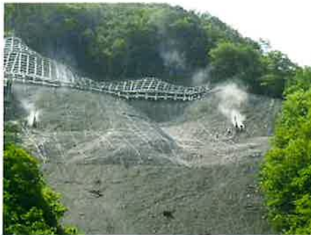
写真-3 ロックボルト施工状況(1)
