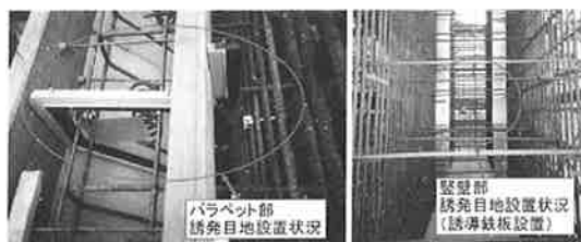
写真-4 誘発目地設置状況
