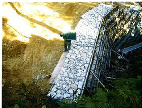
写真二 前面補強（上部）
