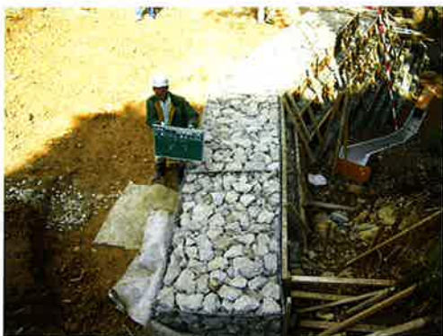
写真四 中間折れ点部完了
