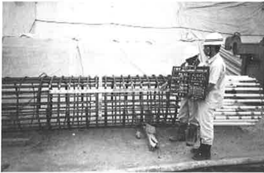
写真－5 施工検査状況
