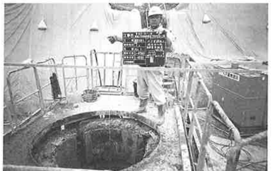
写真-3 鉄筋かご高測定状況
