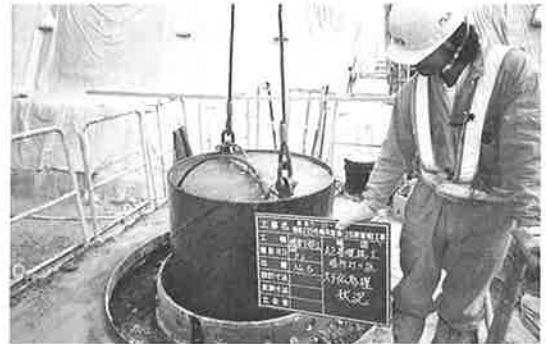
写真-2 スライム処理状況
