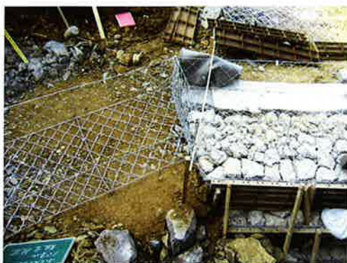
写真三 中間折れ点部パネル組立
