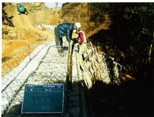
写真一 前面補強（下部）
