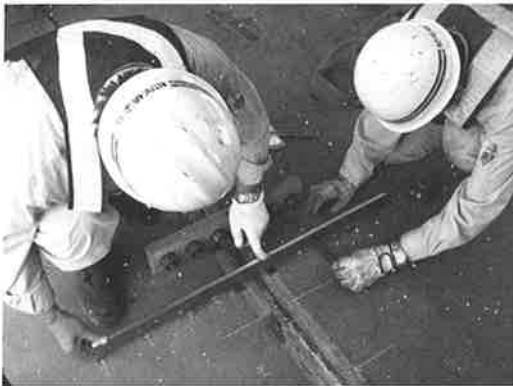
写真－2 角変形計測
