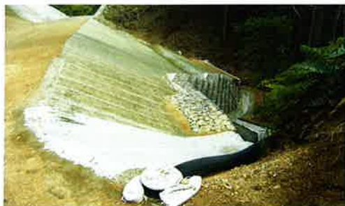
写真五 完成全景
