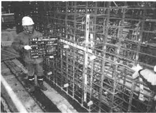
写真－6 配筋寸法確認
