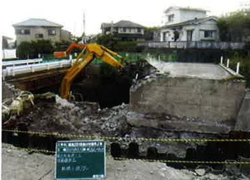
写真-3 大型ブレイカーから油圧クラッシャーに変更
