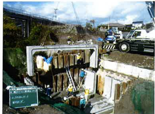
写真-4 ボックスカルバート据付 (上下分割)
