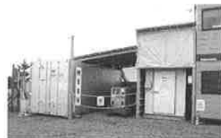
写真一2 NO.2. 3試験用冷凍庫
