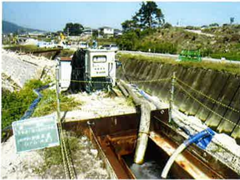
写真-1 沈殿槽・自動アルカリ中和装置設置
