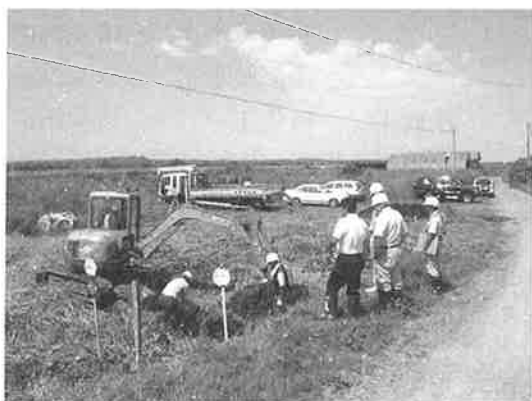
写真-3 水道管試掘状況
