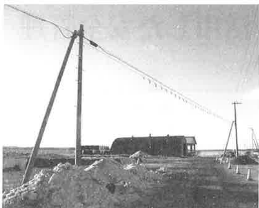
写真-2 三角旗取付け完了
