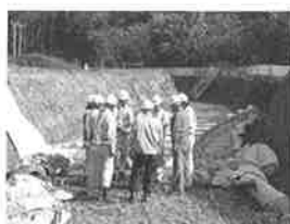
写真-5 重機死角の確認
