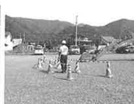
写真-6 作業半径の確認
