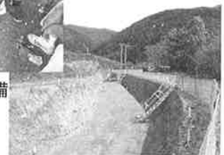
写真一一 転落防止ネット・昇降設備
