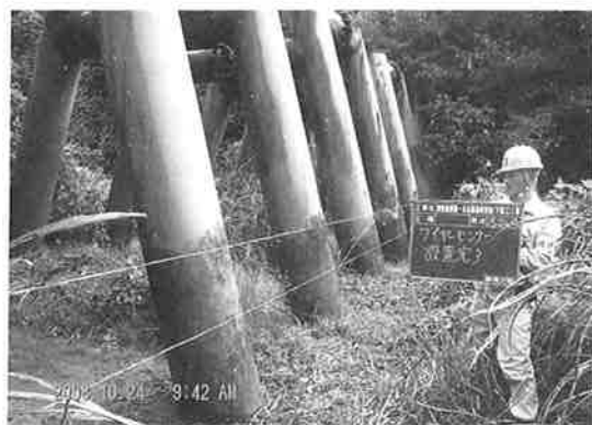
写真-2 ワイヤセンサー設置
