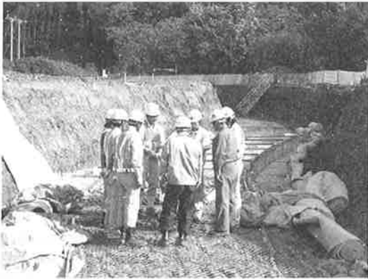
写真一七 現地KY状況
