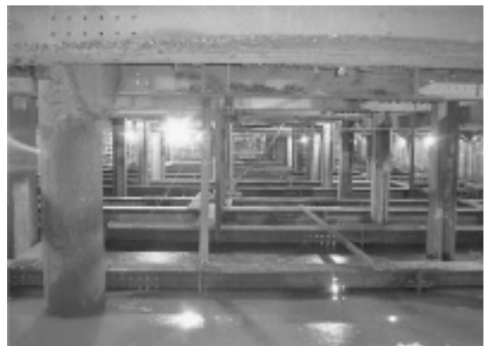
写真-2 掘削部の状況
