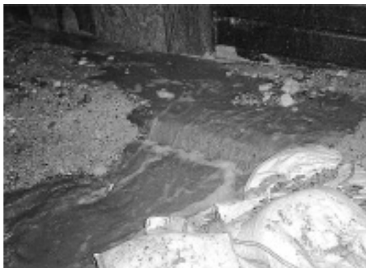
写真-1 欠損部の状況
