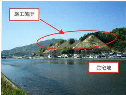
写真一 施工箇所
