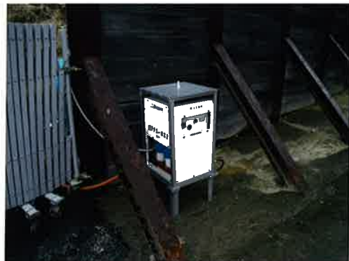
写真二 ポンプユニット設置状況
