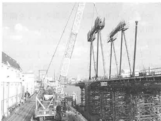
写真-3 桁(アーチ)組立状況
