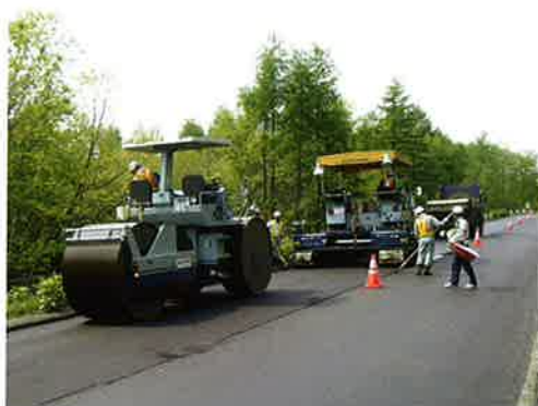
写真ー1 施工状況
