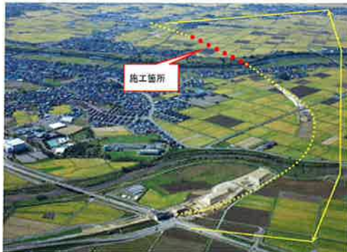
写真－1 施工箇所
