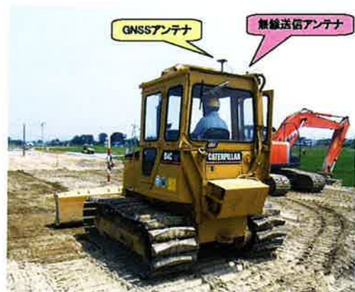
写真－3 GNS及び無線送信アンテナ設置
