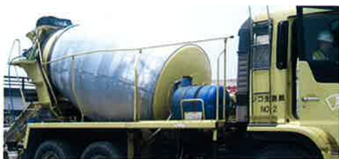
写真-3 コンクリート運搬時遮光カバー設置状況
