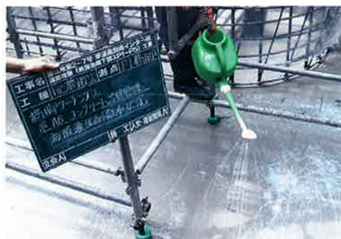
写真-4 初期乾燥ひび割れ防止（被膜養生剤使用）
