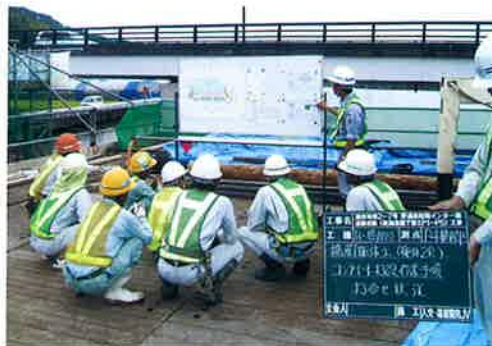
写真-2 コンクリート打設手順確認会の状況
