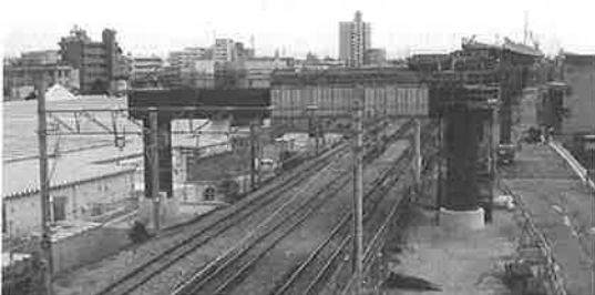
写真-1 (下部工) 完成状況
