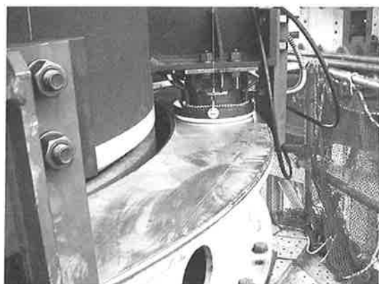
写真-5 柱外部（外周ジャッキ設置状況）
