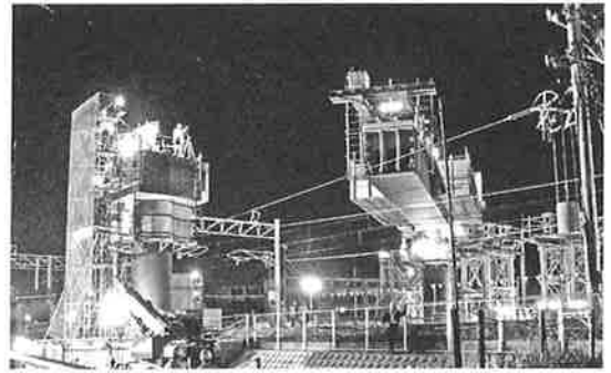
写真－3 回転架設状況
