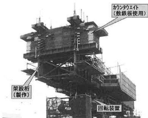
写真-2 設備組立完了（回転前）
