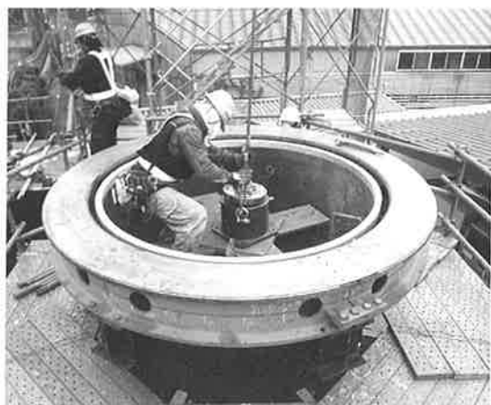
写真-4 柱内部（ピボット脊仮設置状況）
