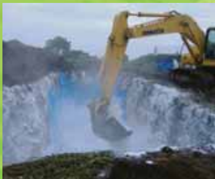
消石灰消毒作業
